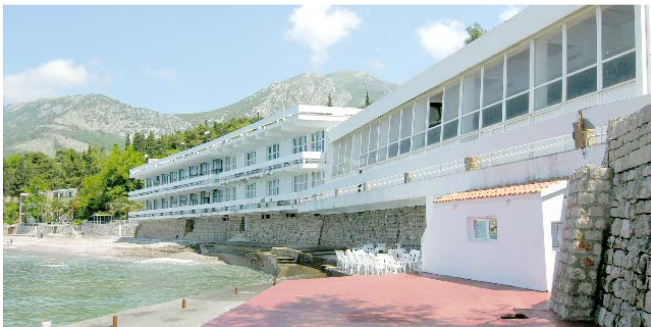
Foto: Centralni objekat kompleksa - levi deo (restoran i ostali sadržaji), desno, zatvoreni bazen
