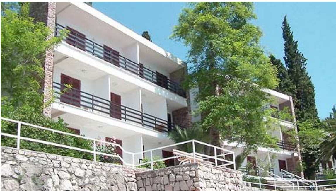
Foto: Dva smeštajna objekta sa 3 nivoa
